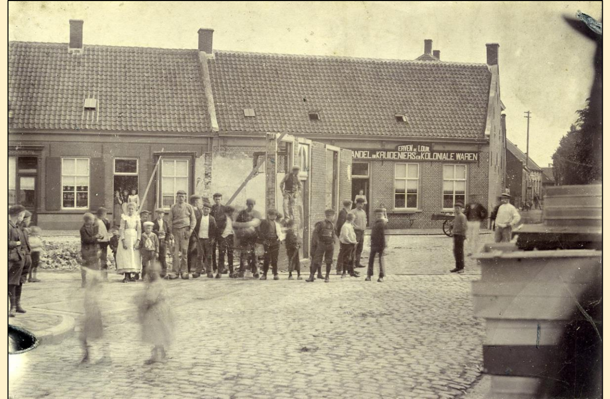
Bron: Stadsarchief Oss ( Het Tolhuis wordt afgebroken, 1902 ).
