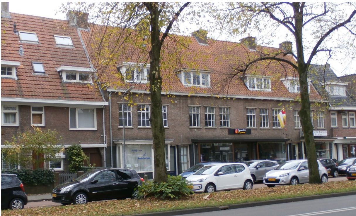
afbeelding 12: de in afwijkende stijl herbouwde 4 dubbelwoningen aan de Graafseweg nrs. 139-153 (foto auteurs; april 2022)
