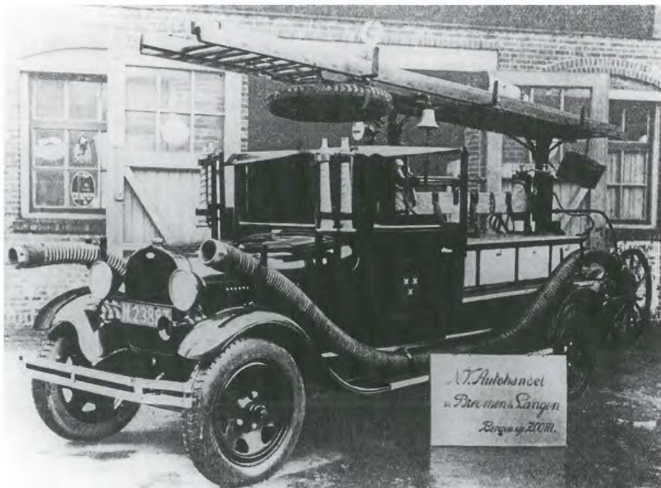
Afb. 8. Motorspuitwagen van de Bergse brandweer met carrosserieopbouw door de N.V. Autohandel Van Breemen & Langen , op een chassis van een Ford TT. Het kenteken was afgegeven in 1929. Foto collectie Fred van Breemen.
